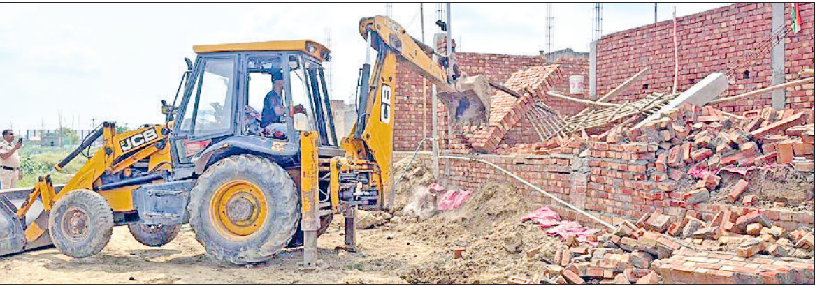
कैथल। पट्टी चौधरी में अवैध निर्माण को हटाती जैसीबी।
